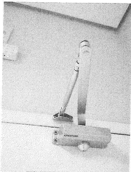
Depois – Instalação de molas com ajustes realizados.
