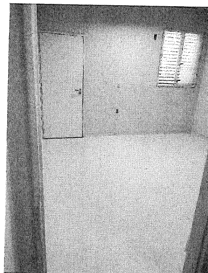
Depois – Portas e batentes instalados e validados.
