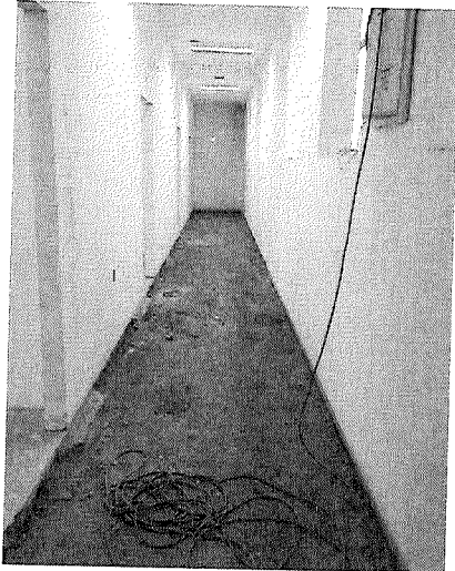
Antes – Abertura dos vãos, regularização e emassamento.
