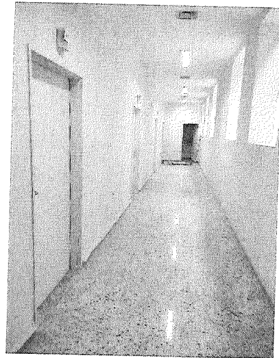
Depois – Portas e batentes instalados e validados.
