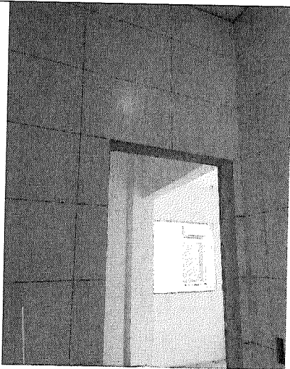
Antes – Abertura dos vãos, regularização e assentamento de revestimentos.
