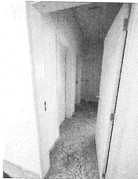
Depois – Portas e batentes instalados e validados.
