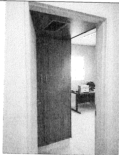
Depois – Portas e batentes instalados e validados.
