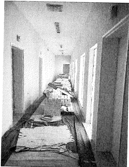
Depois – Portas e batentes instalados e validados.
