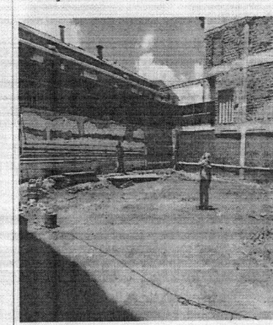
Foto 4 - Acompanhamento topográfico para marcação de eixos e locação dos tubulões
