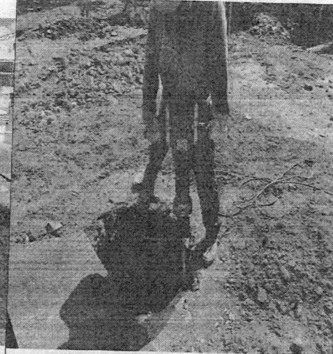
Foto 12 – Continuação da escavação dos tubulões.
