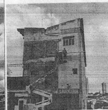
Foto 28 - Utilização de PTA para correção de tubulação hidráulica danificada
