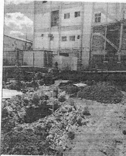
Foto 9 – Continuação da escavação dos tubulões.
