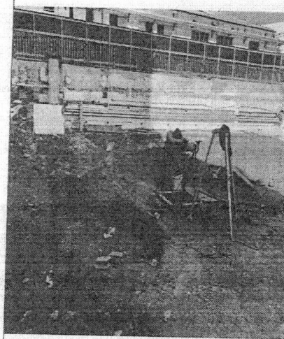
Foto 11 – Continuação da escavação dos tubulões.
