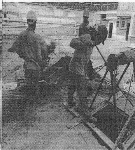
Foto 24 - Continuação da escavação dos tubulões
