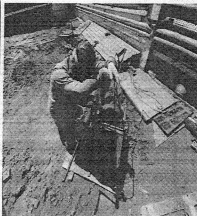
Foto 15 - Continuação da escavação dos tubulões
