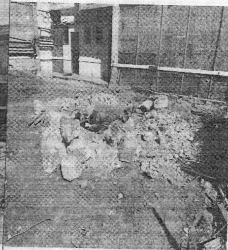
Foto 12 – Continuação da escavação dos tubulões.
