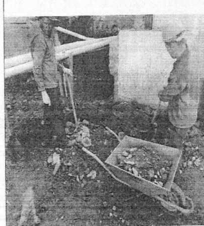
Foto 25 - Remoção de entulho
