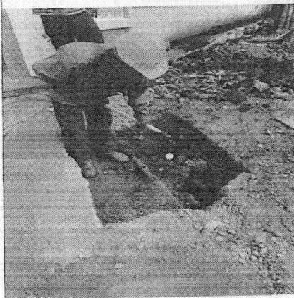
Foto 31 - Continuação da escavação dos tubulões.
