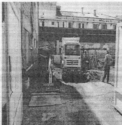
Foto 22 - Remoção do solo removido dos tubulões
