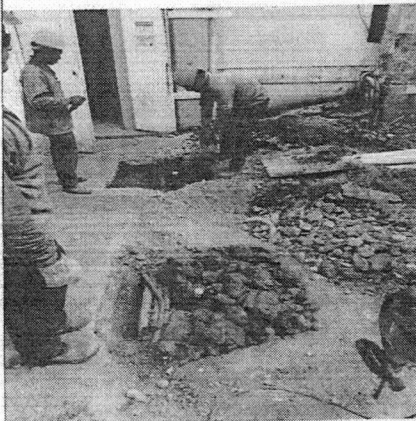
Foto 31 - Continuação da escavação dos tubulões.
