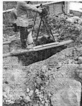
Foto 6 - Continuação da escavação dos tubulões.
