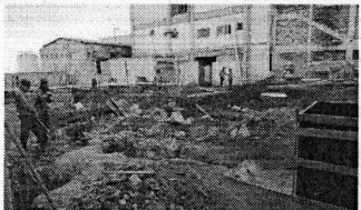
Foto 59 – Armação das vigas baldrame e posicionamento da armação dos blocos de fundação.
