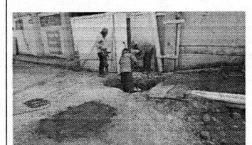
Foto 28 - Continuação da escavação dos tubulões.
