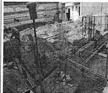
Foto 64 – Posicionamento da armação dos blocos e lastro de brita sobre o baldrame.
