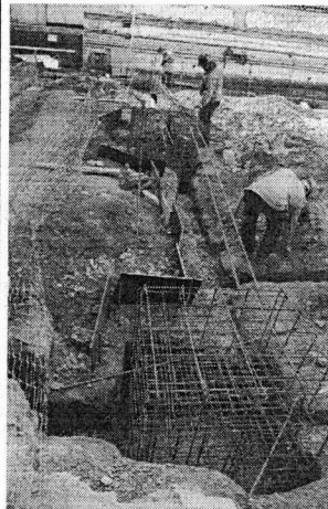
Foto 65 - Escavação do bloco de fundação do elevador.
