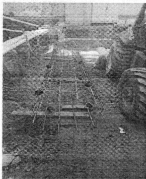
Foto 33 - Armação pronta dos tubulões
