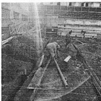
Foto 69 – Início de concretagem dos blocos de fundação e vigas baldrame.
