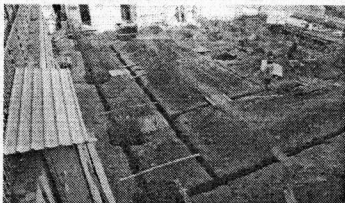
Foto 60 – Vista superior da obra, das vigas baldrame e blocos posicionados.
