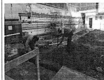
Foto 52 - Continuação da abertura dos blocos de fundação e vigas baldrame.
