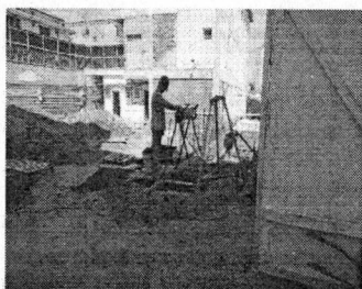
Foto 32 Continuação da limpeza da camada de terra para nivelamento.
