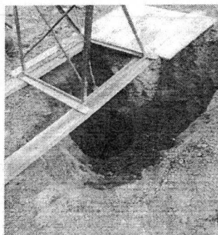
Foto 43 - Início da montagem das formas dos blocos.
