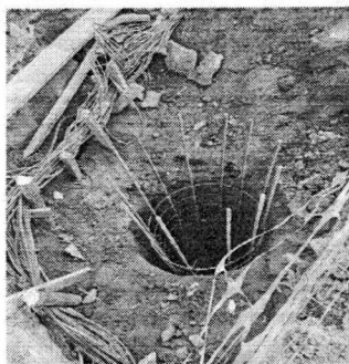
Foto 45 - Posicionamento de armadura dos tubulões para concretagem.
