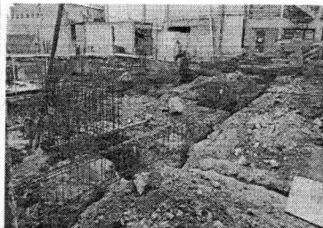
Foto 66 - Posicionamento da armação dos blocos e lastro de brita sobre o baldrame.
