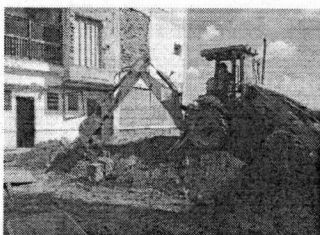
Foto 34 - Continuação da escavação dos tubulões.
