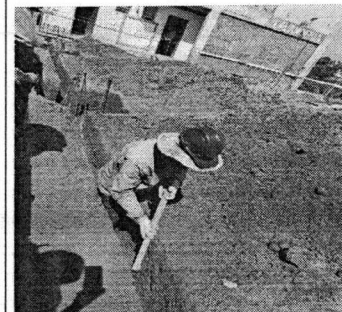
Foto 50 - Forma dos blocos de fundação.
