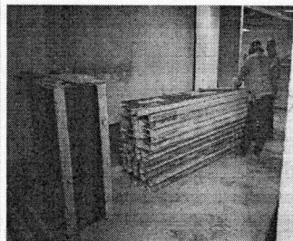
Foto 56 - Continuação da montagem das formas dos pilares.
