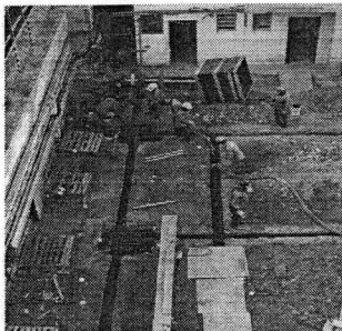
Foto 71 – Continuação da concretagem dos blocos de fundação e vigas baldrame.
