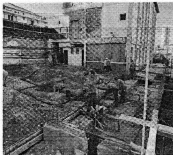
Foto 70 – Continuação da concretagem dos blocos de fundação e vigas baldrame.
