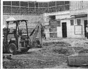
Foto 18 – Continuação da escavação dos tubulões.
