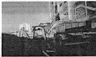
Foto 19 Continuação da escavação dos tubulões.
