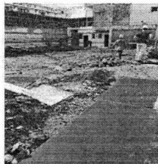
Foto 3 - Continuação da escavação dos tubulões.
