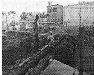
Foto 55 - Continuação da abertura dos blocos de fundação e vigas baldrame.
