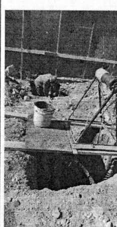
Foto 13 - Continuação da escavação dos tubulões.
