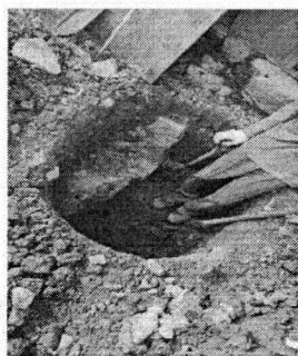
Foto 5 - Continuação da escavação dos tubulões.
