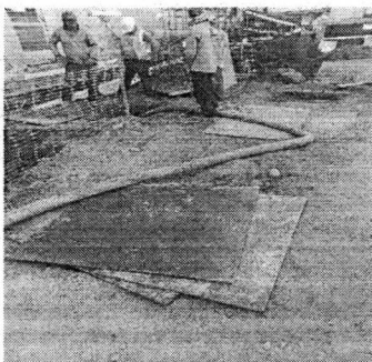
Foto 46 - Concretagem do restante dos tubulões.
