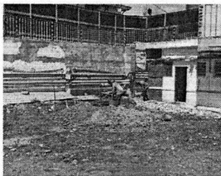
Foto 5 - Continuação da escavação dos tubulões.
