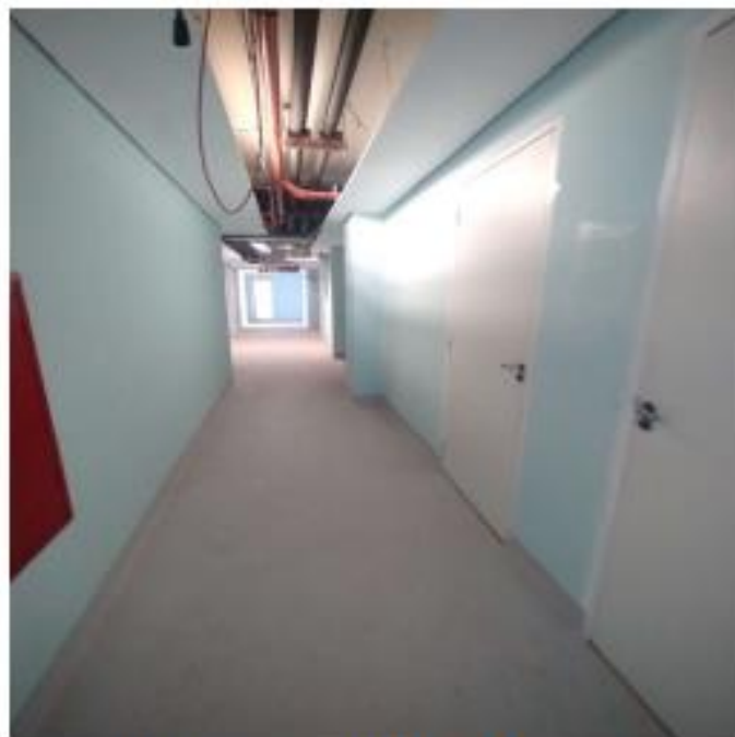
Instalação do sistema de climatização.
