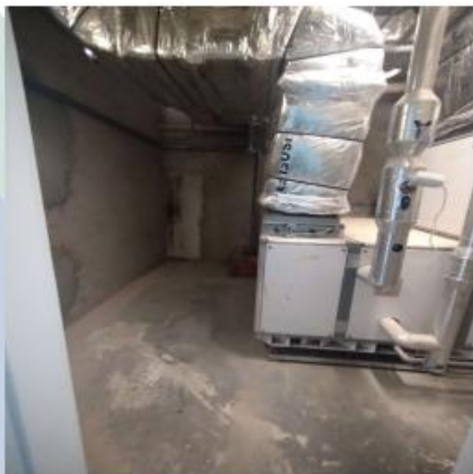
Instalação do sistema de climatização.
